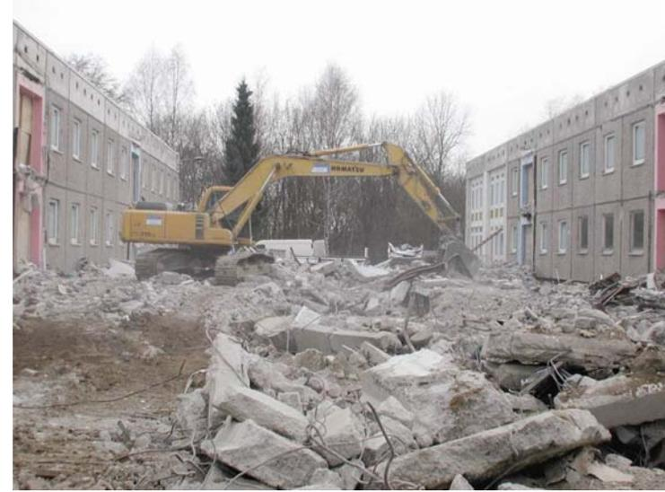
Abbruch der Verbindungsflure zwischen den Teilgebäuden
